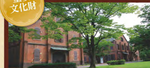
旧金澤陸軍兵器支廠兵器庫 所在地：金沢市出羽町3-1 (いしかわ赤レンガミュージアム) 竣工年：明治42年[第3棟]、大正2年[第2棟]、大正3年[第1棟(道路側)]
