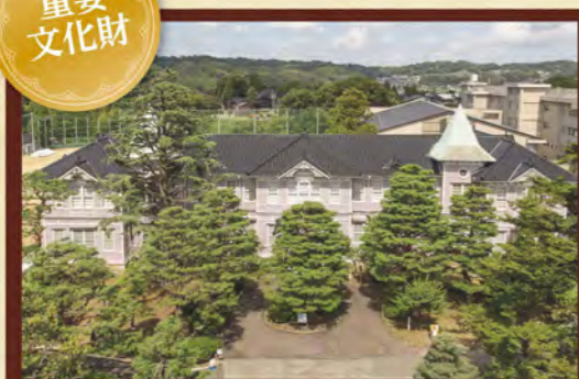
旧石川県第二中学校本館 所在地：金沢市飛梅町3-31(金沢くらしの博物館) 竣工年：明治32(1899)年 設計者：山口孝吉(石川県技師)
